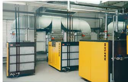
Nuevo sistema de aire comprimido: bajo consumo energético
